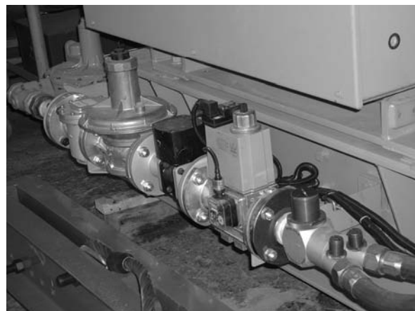
Типичный монтаж газовой магистрали Метод «трапеции» (слева), и метод «основания» (справа)
